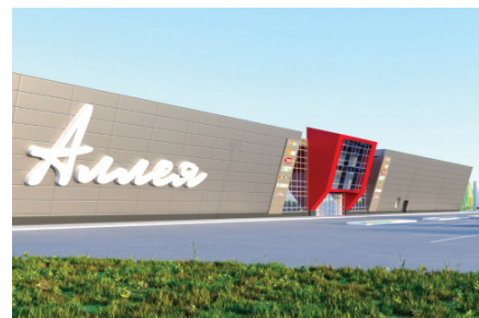
г. Южно-Сахалинск, ТРЦ Аллея АРМ «Ресурс» 210 ПУ; водосчетчики BOLID СВК-15-3-2-Б 100 шт.
