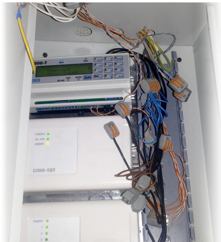
Рис.2. Шкаф автоматики в процессе монтажа.
