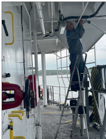
Монтаж камер видеонаблюдения на судне
