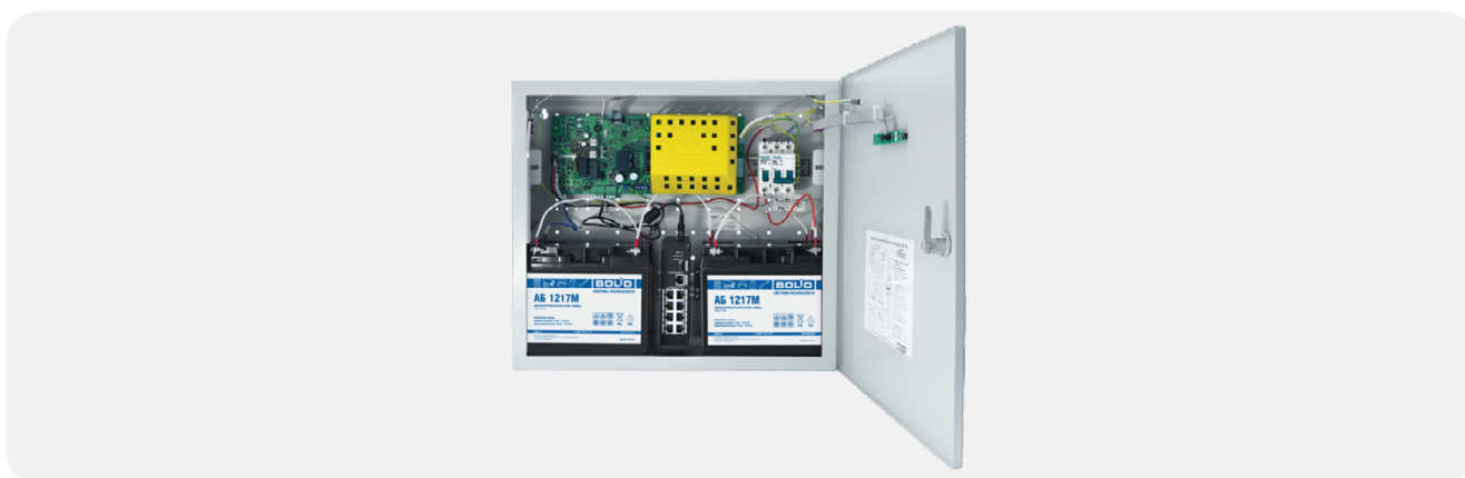
Рисунок 81. РИП-48 исп.01 с установленным внутри коммутатором SW-108
