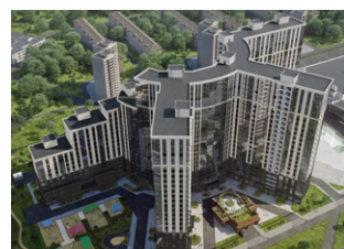
г. Санкт-Петербург, ЖК «Питер», АРМ «Ресурс» 6310 ПУ
