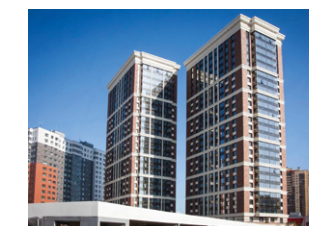
г. Санкт-Петербург, ЖК «Бау Хаус», АРМ «Ресурс» 2010 ПУ
