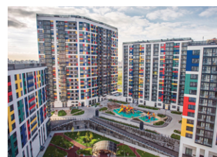
г. Санкт-Петербург, ЖК «Легенда на Оптиков», АРМ «Ресурс» 5000 ПУ
