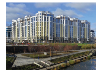
г. Екатеринбург, ЖК «Клубный Дом Ривьера», АРМ «Ресурс» 3610 ПУ
