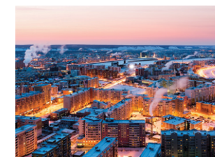
г. Якутск, УК «Прометей+», под управлением 340 МКД АРМ «Ресурс» 7000 ПУ
