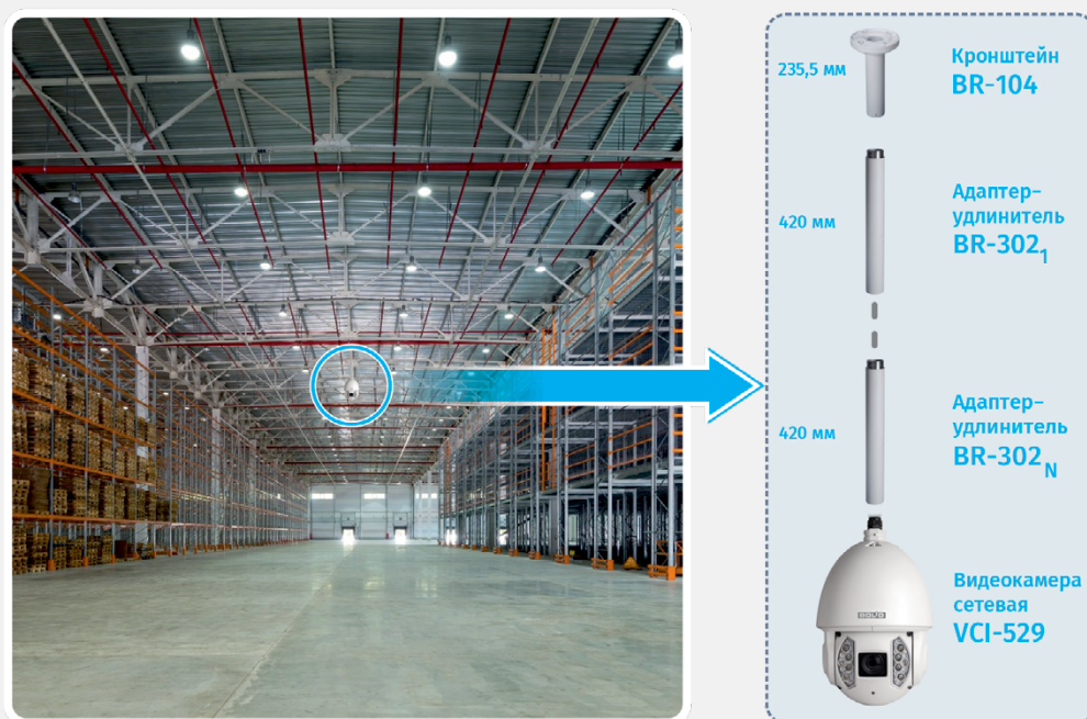
ПРИМЕР МОНТАЖА КАМЕРЫ НА ВЫСОКИЙ ПОТОЛОК
